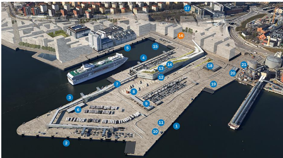
Figur 41 Värtahamnen efter ombyggnad (Stockholms hamnar, 2016)
