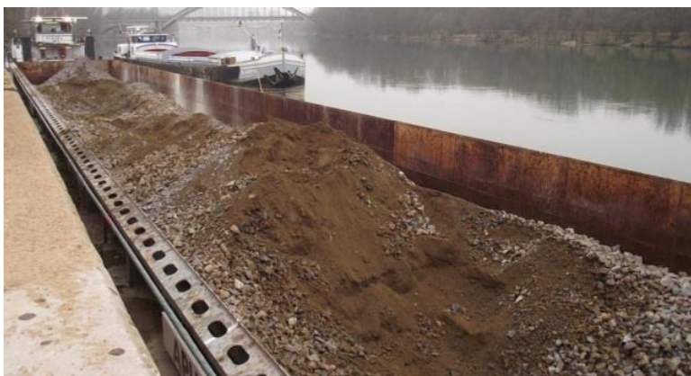
Figur 35. En pråm med 2 200 tons kapacitet utnyttjades för bortforsel av byggavfall i Croix Rousse tunneln i centrala Lyon (Free.fr, 2008)
